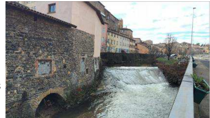
Vue sur le seuil Sapéon avant travaux © SYRIBT
